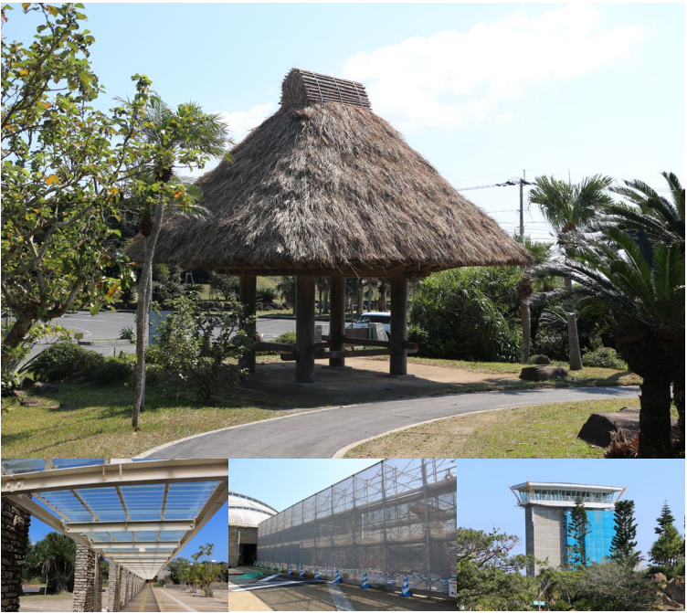
パーク入口にある高倉の葺き替えと奄美の郷と美術館を繋ぐ回廊部分の屋根が完了。（令和2年2月時点）
